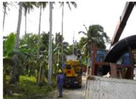
Line works at Sitio Ilaya, Brgy Antipolo, San Pascual, Batangas
